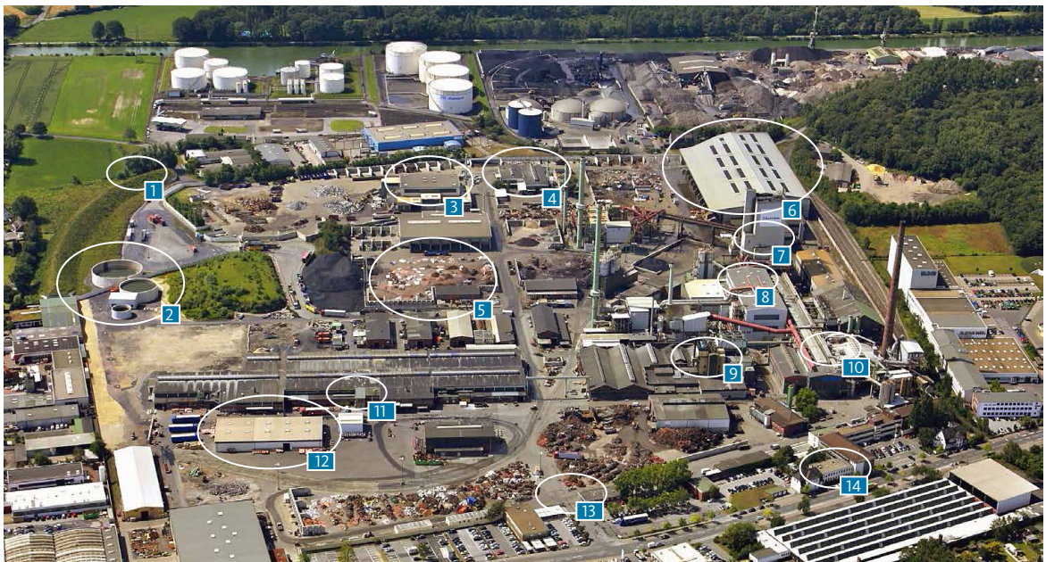
Abb. 3.1: Anlagenübersicht des Standorts Lünen
