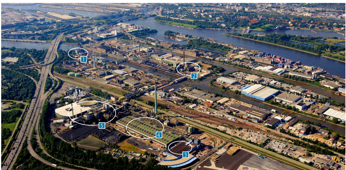
1 Stranggussanlage 2 Sekundärhütte/Edelmetalle 3 Rodanlage 4 Elektrolyse 5 Rohhütte Ost
