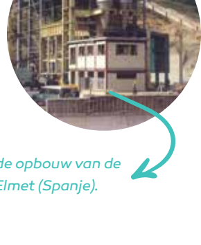
Beeld van de opbouw van de gieterij bij Elmet (Spanje).
